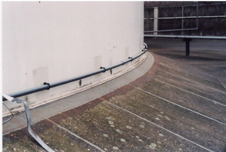
Bild 5: Tankfußabdichtung mit Polysulfidbändern
